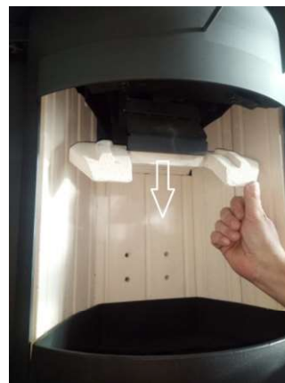
3. Spustit a vytáhnout betonový deflektor.
